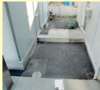
施工前 [事務所]
