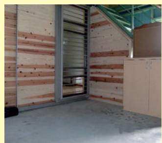
施工前 [室内の段差]
