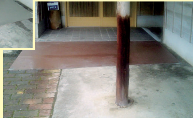
施工後 段差解消スロープ
