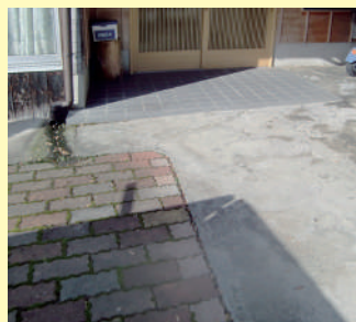
施工前 [玄関前の段差]
