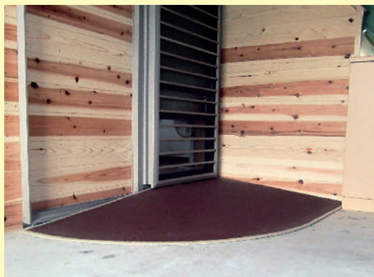
施工後 段差解消スロープ（全方向対応）
