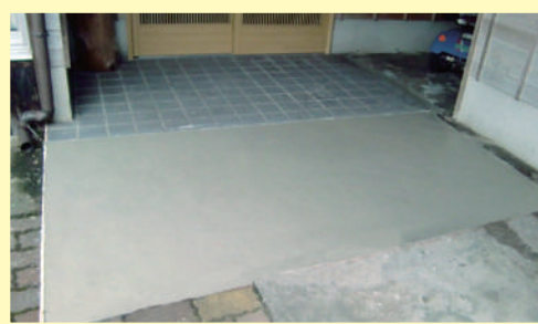
施工中 セメントコテめり 厚みが薄いセメントの ひび割れを防ぐ
