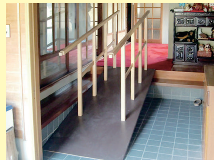
施工後 段差解消スロープ（歩行者用手摺付）
