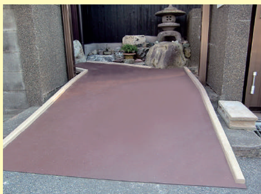
施工後 段差解消スロープ （不陸調整法にて設置・原状復帰可能）
