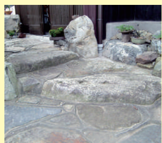
施工前 [石だたみの階段]
