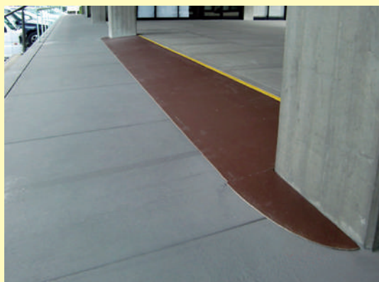
施工後 段差解消スロープ（立体物に合わせて対応）
