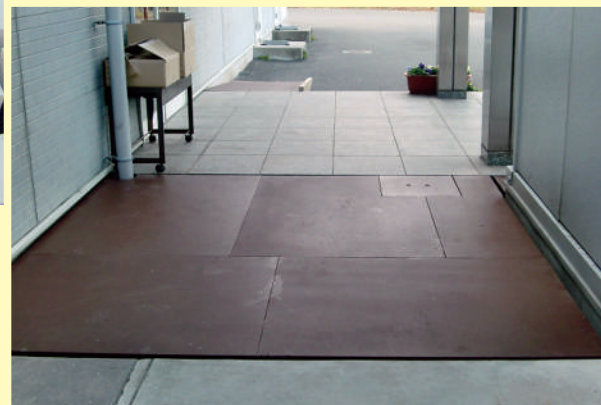
施工後 段差解消（不陸調整法）
