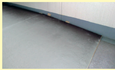
施工後 薄い段差で自操可能 床と同色（グレー）に しました
