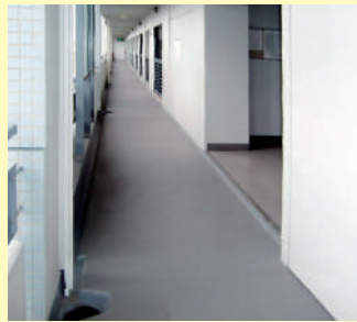
施工前 [マンション]
