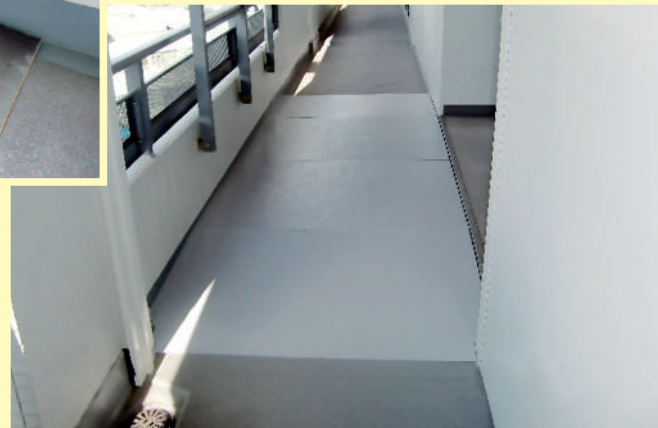
施工後 段差解消スロープ
